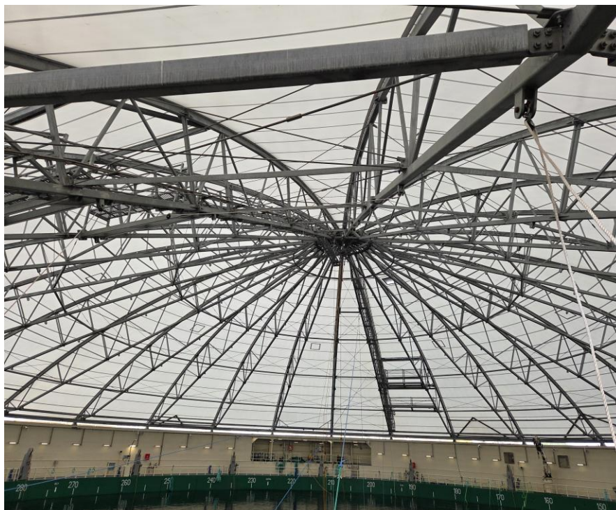
Figure 5. Takkonstruksjon fra innsiden gangbaner, luker og løftepunkt.
