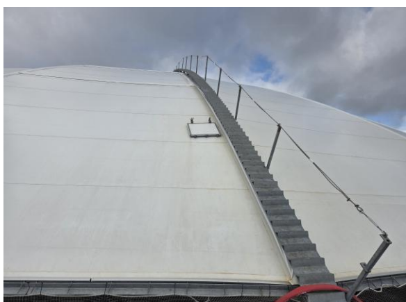
Figure 6. Takkonstruksjon fra utsiden med gangbane og tilkomstluke for indre gangbane.
