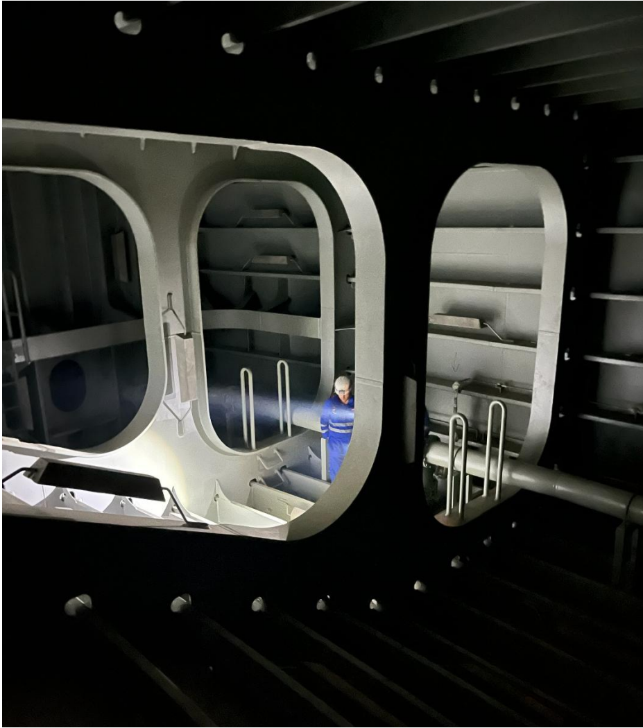
Figure 4: Inspeksjon av ballasttank i nedre pongtong.
